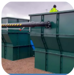
Réacteur MBBR : réacteur à lit mobile avec des bactéries aérobies.
