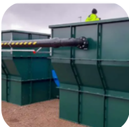
Réacteur MBBR : réacteur à lit mobile avec des bactéries aérobies. MBBR Reactor: Moving bed reactor with aerobic bacteria
